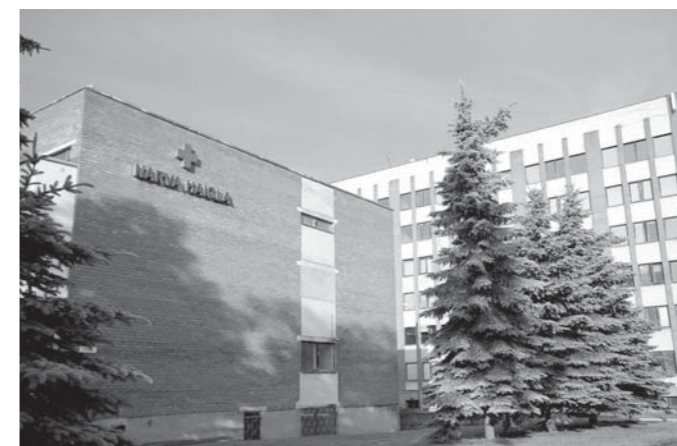
Naistekliiniku ja kirurgiakliiniku hoone.
