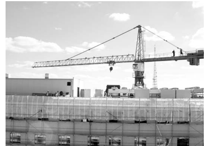
K-korpuse tornkraana demonteerimine
